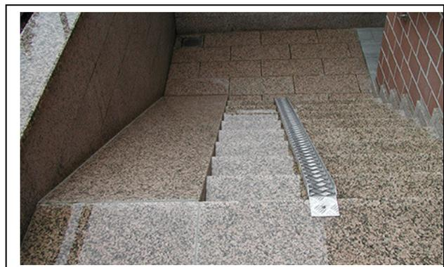
Beispiel eines U-Profils zur Führung von Rädern.
